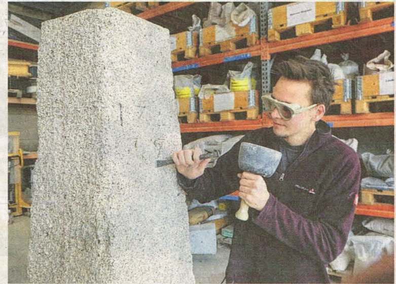
Steinmetz Elias Hauptmann hat mit der Restaurierung der Postmeilensäule von 1725 begonnen. FOTO: FRANKO MARTIN
