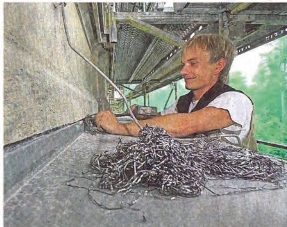
Steinmetz Marco Strobel beim Verstemmen der Blechanschlussfugen. Dabei wird Bleiwolle in die Fuge zwischen Sandstein und Blech gestopft und zu einer glatten, elastischen Schicht verdichtet.
