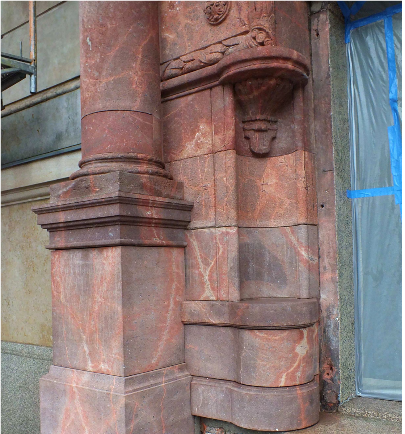
Endzustand nach erfolgreichem Einbau
