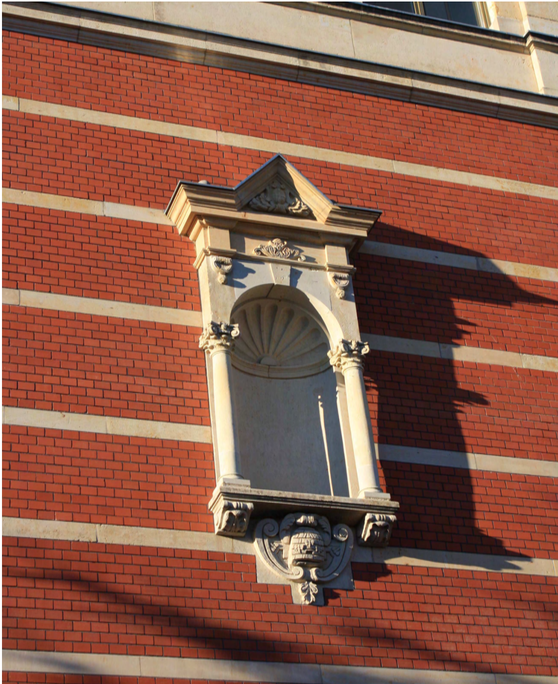
Fertig eingebautes und restauriertes Fassadenelement
