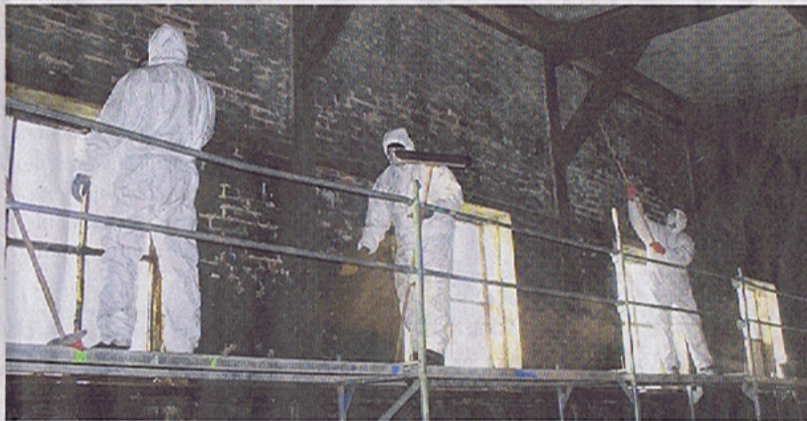
Mitarbeiter der Firma Hollerung haben im Kesselhaus des Kraftwerks Peenemünde mit der Innenreinigung begonnen. Sie tragen wegen des Kohlenstaubs Schutzanzüge.
