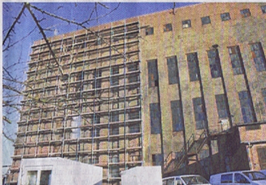
Das Kesselhaus ist zu einem Drittel eingerüstet.
