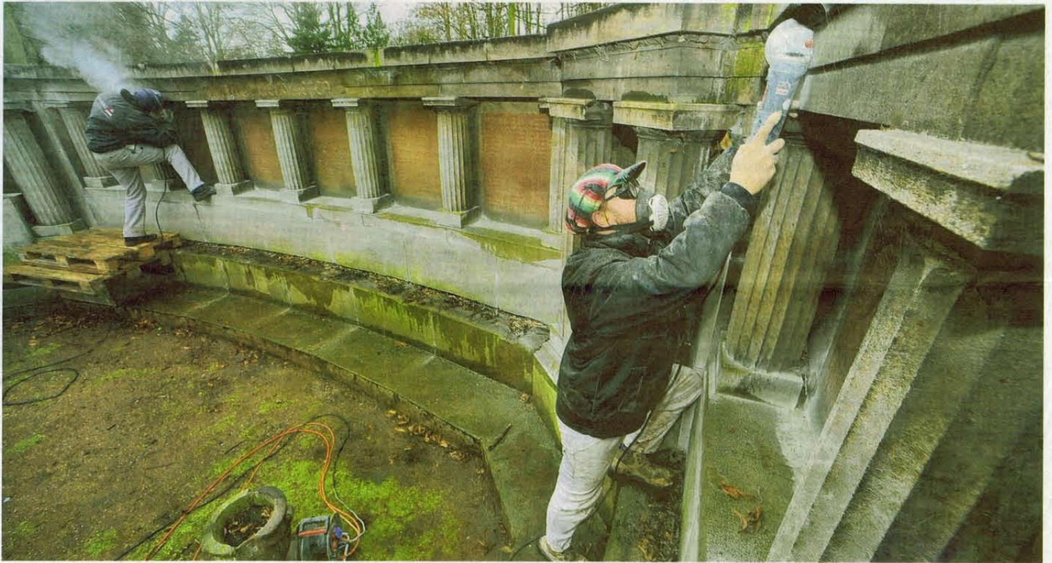
Frank Teuchert (rechts) und Tino Roßbach von der Reichenbacher Firma Hollerung schleifen die Mauerfugen an der Gedenkstätte mit Winkelschleifern aus.
