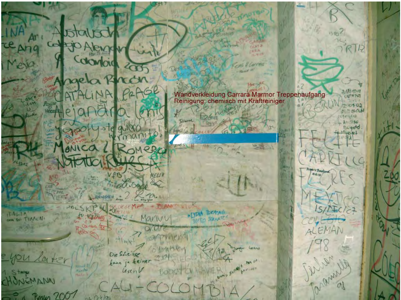
Abbildung 27 Wandverkleidung mit Reinigungsprobe
