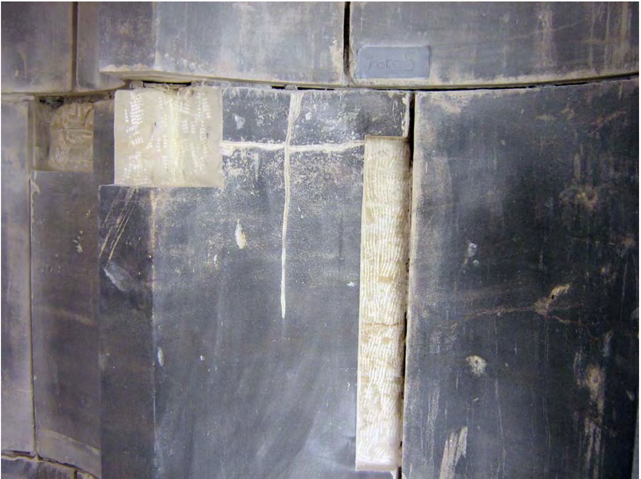
Abbildung 17 Schadstellen ausgearbeitet
