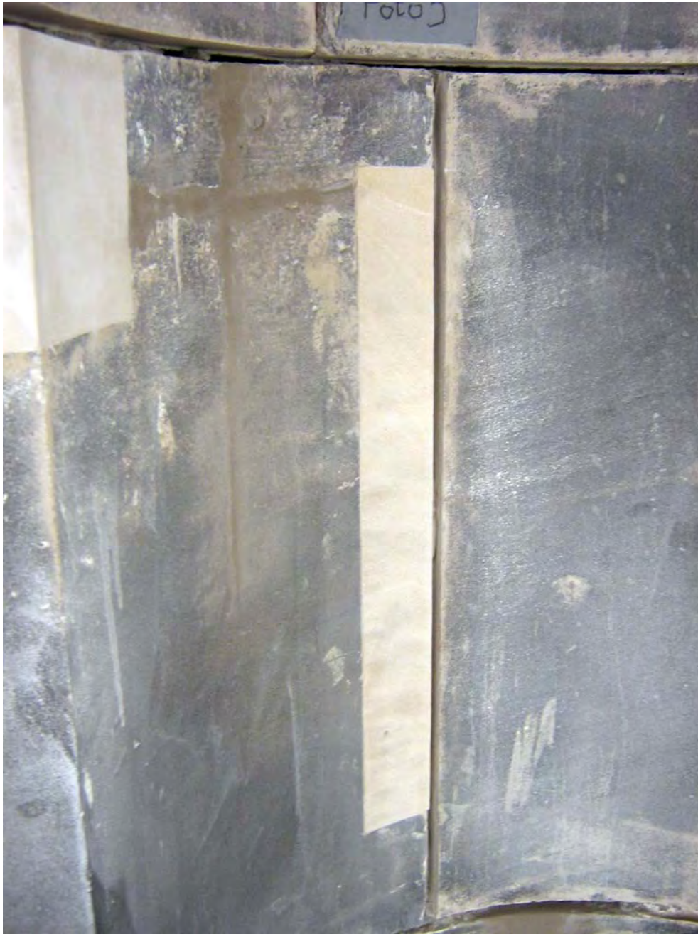
Abbildung 18 Vierungen an Steinkanten
