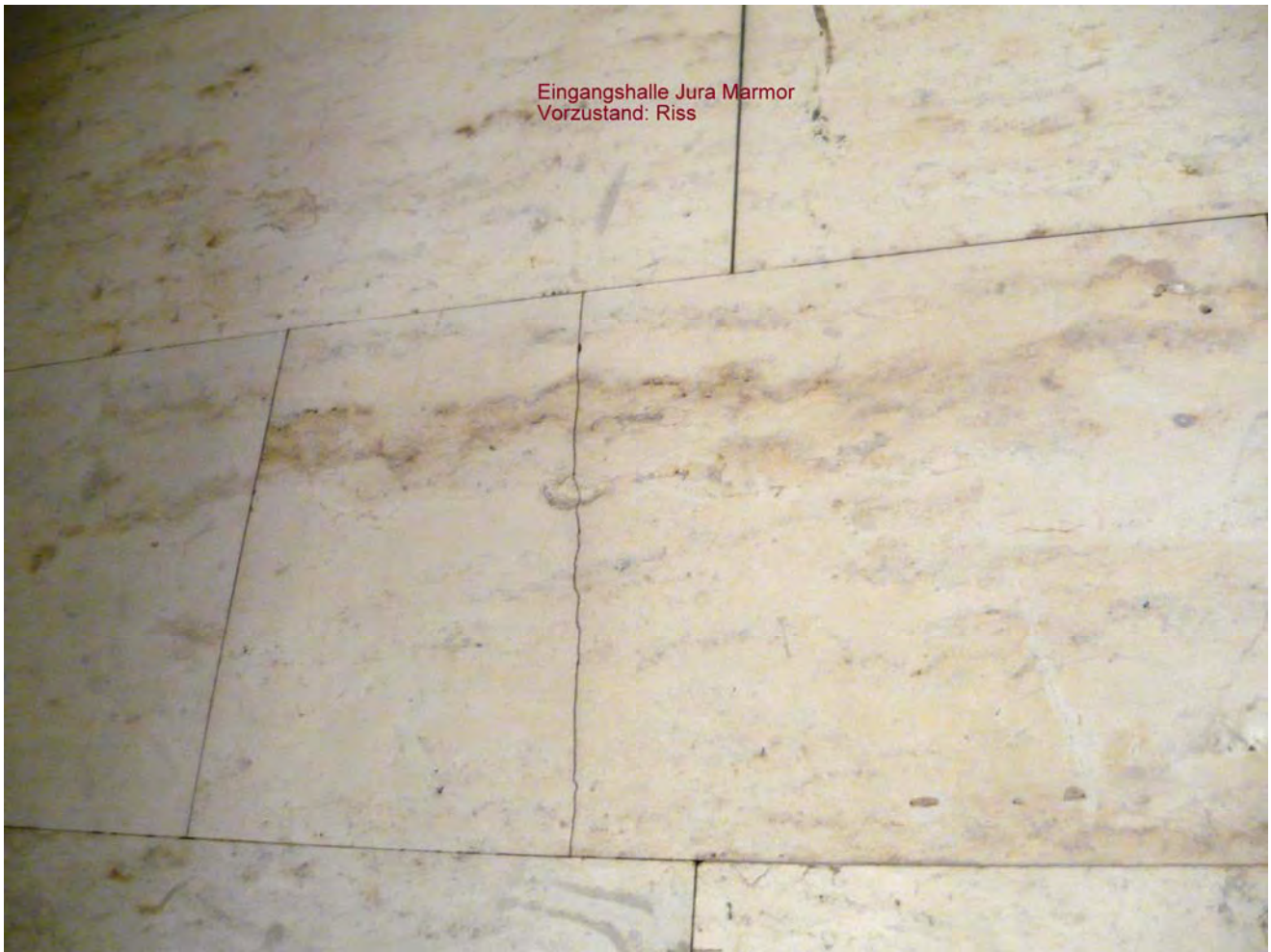
Abbildung 25 Eingangshalle Riss
