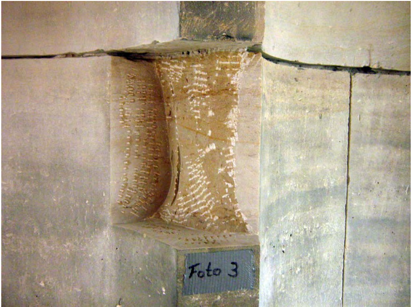
Abbildung 3 Säulenschaft, Ausarbeitung der Schadstelle
