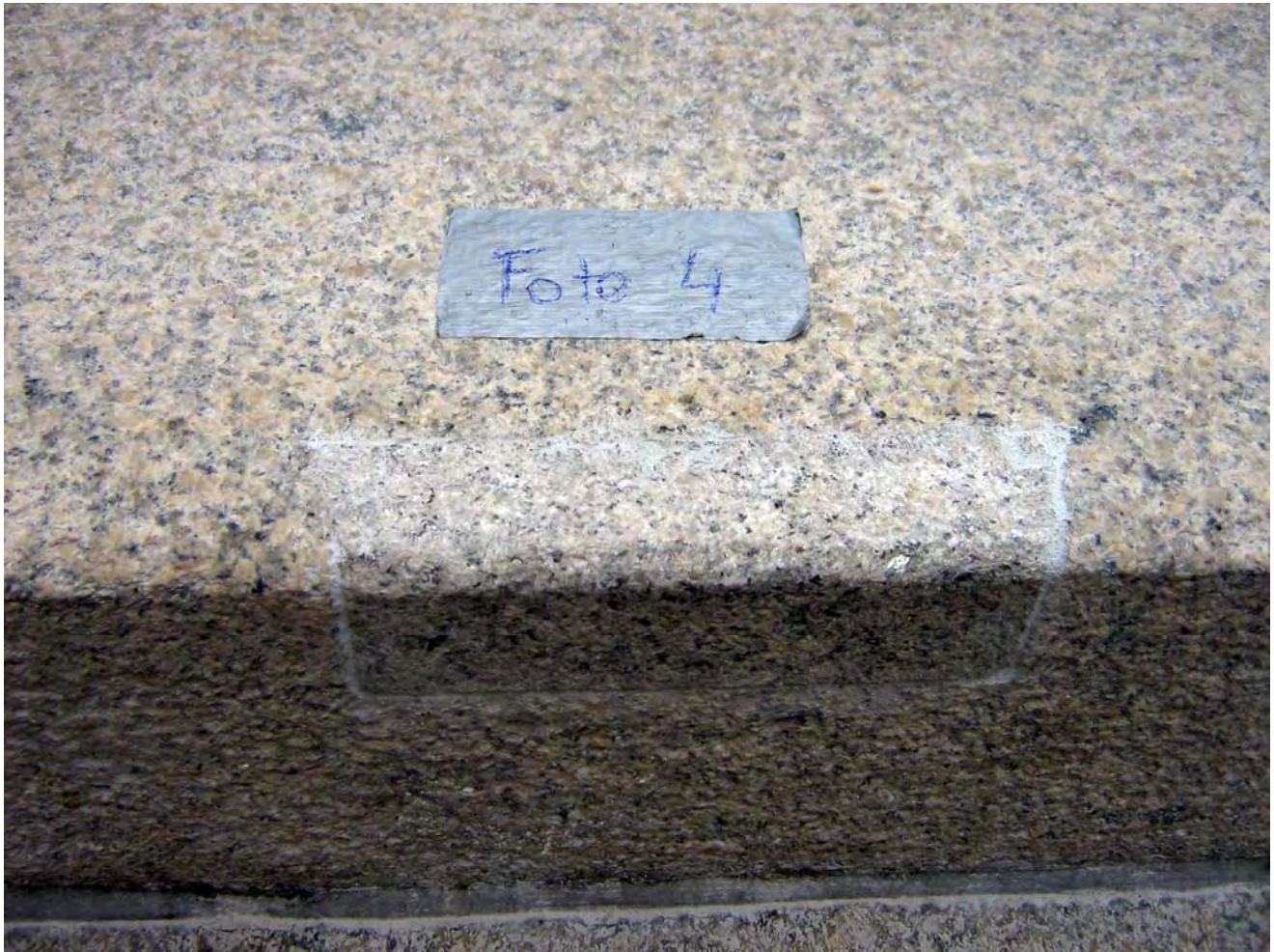
Abbildung 48 Vierung an Kante
