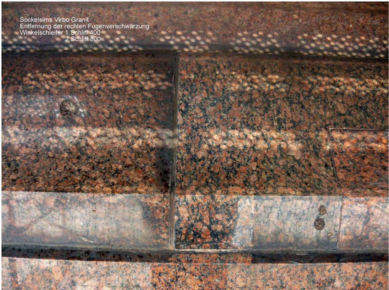
Abbildung 31 Sockelgesims mit Teilreinigung
