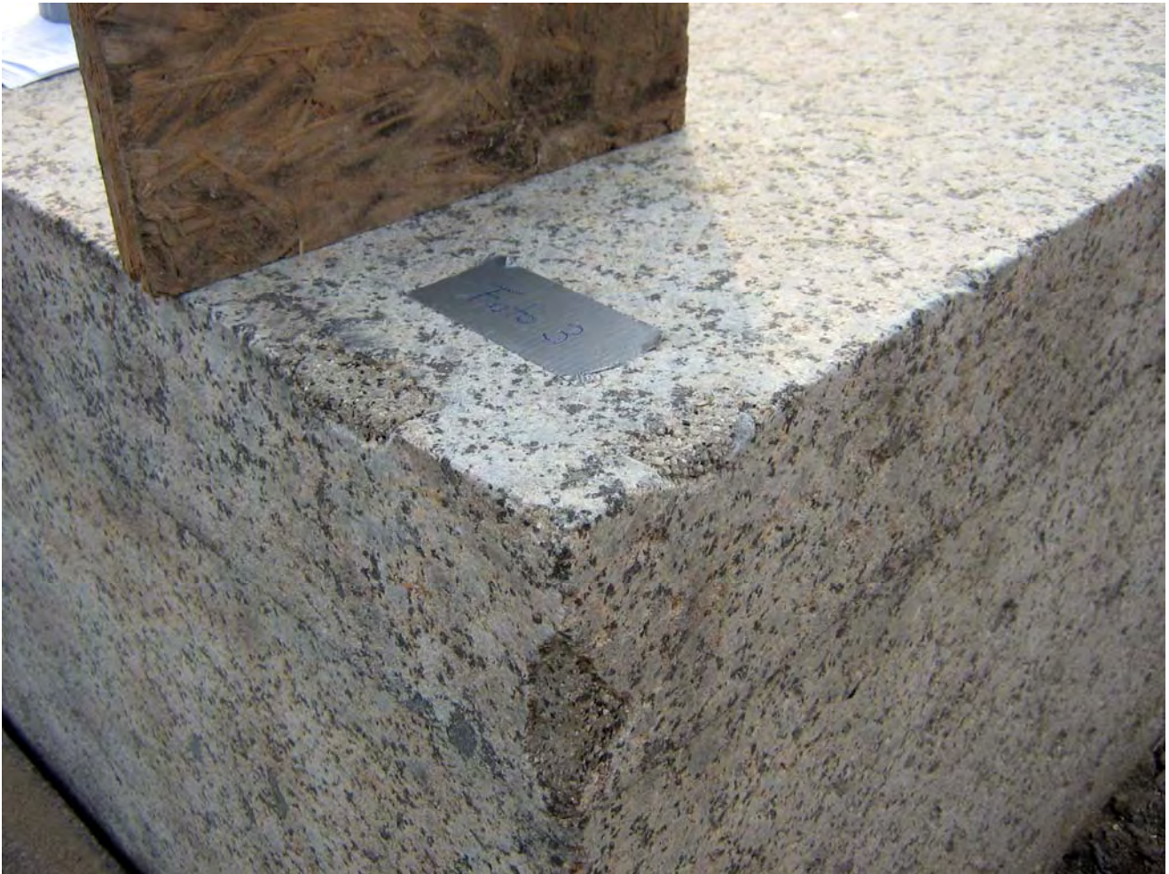
Abbildung 49 schadhafte Altergänzungen
