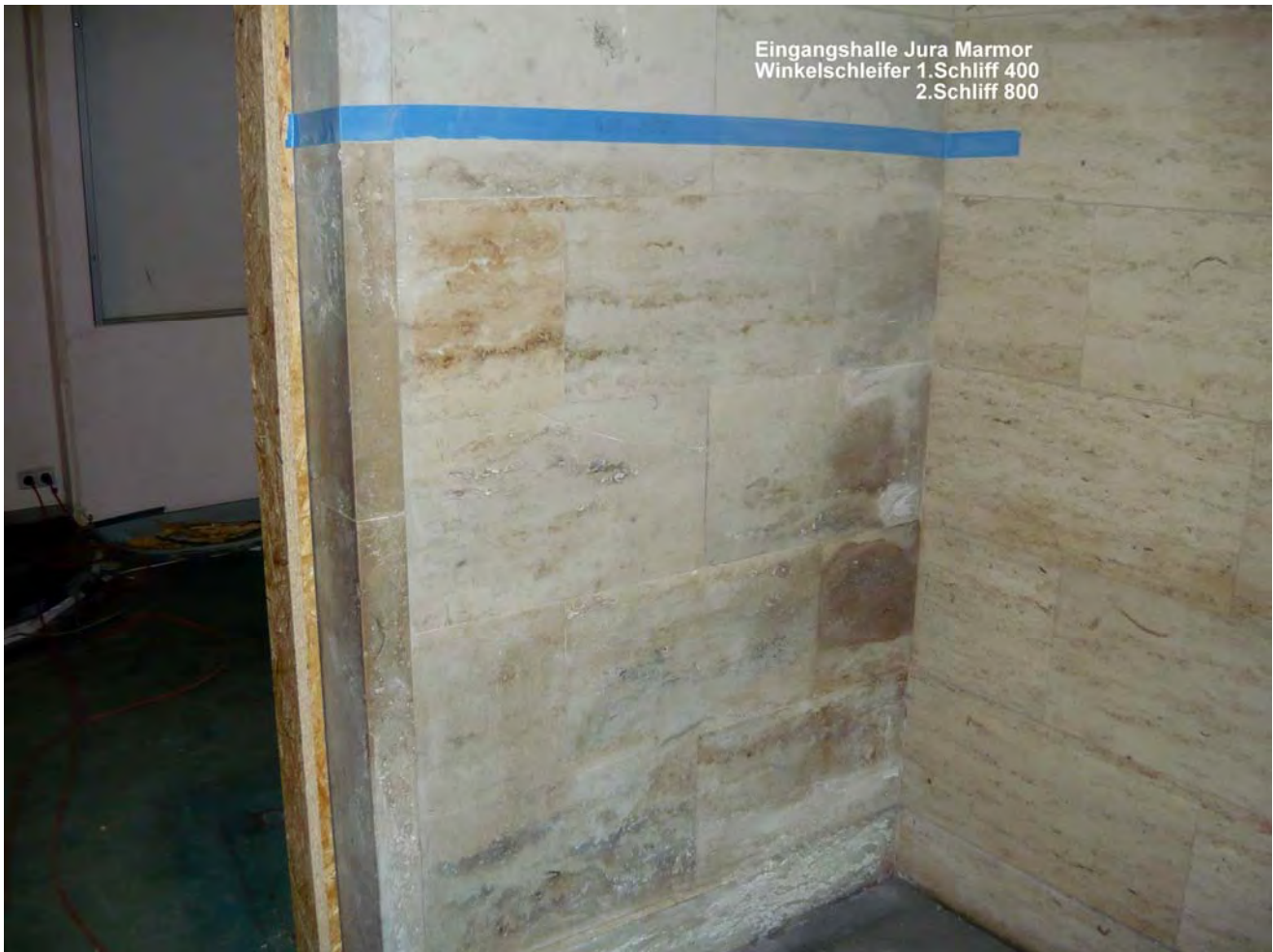
Abbildung 32 Eingangshalle geschliffen
