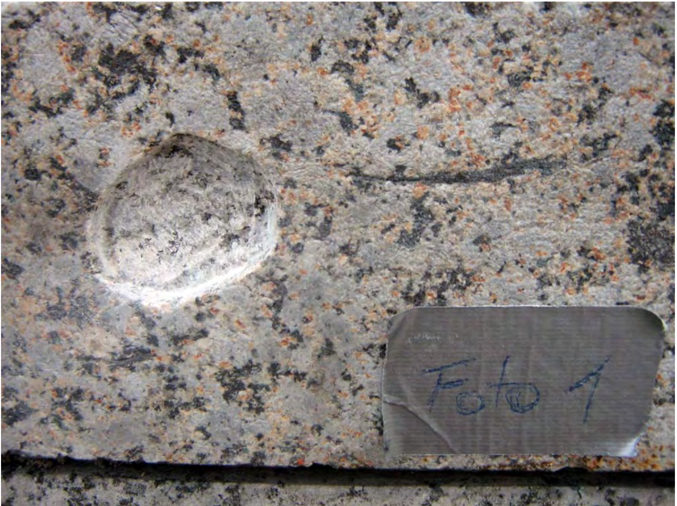
Abbildung 35 Ausarbeitung der Altergänzung
