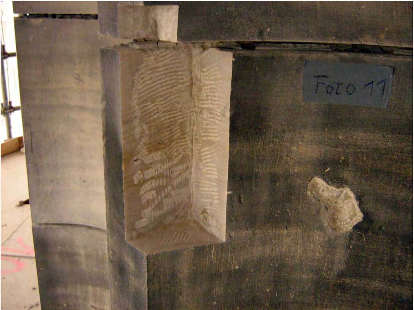
Abbildung 6 Ausarbeitung an Altergänzungen
