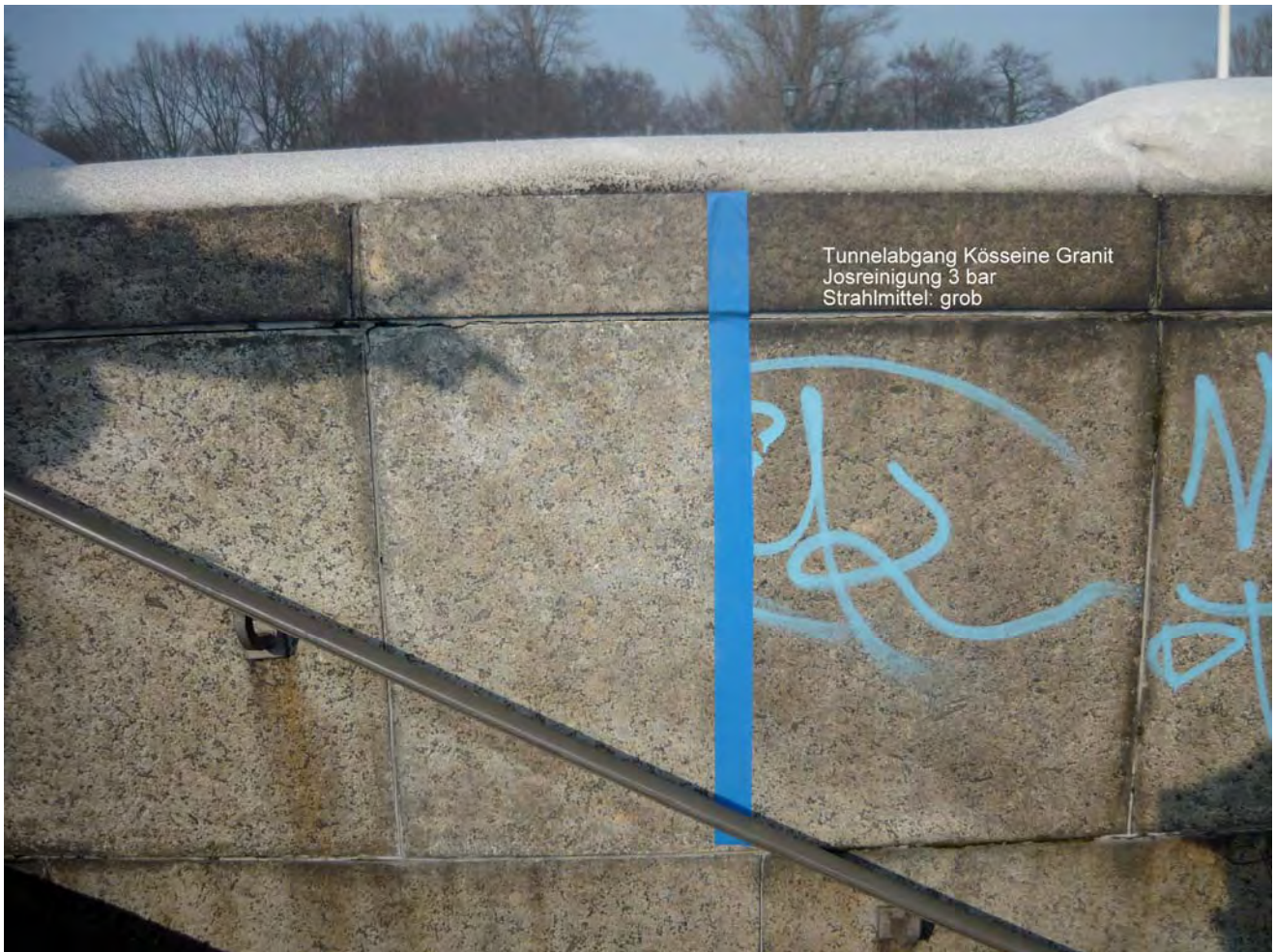
Abbildung 33 Tunnelabgang mit Reinigungsprobe
