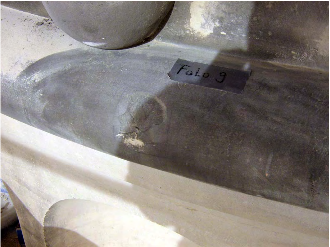
Abbildung 8 schadhafte Altergänzung
