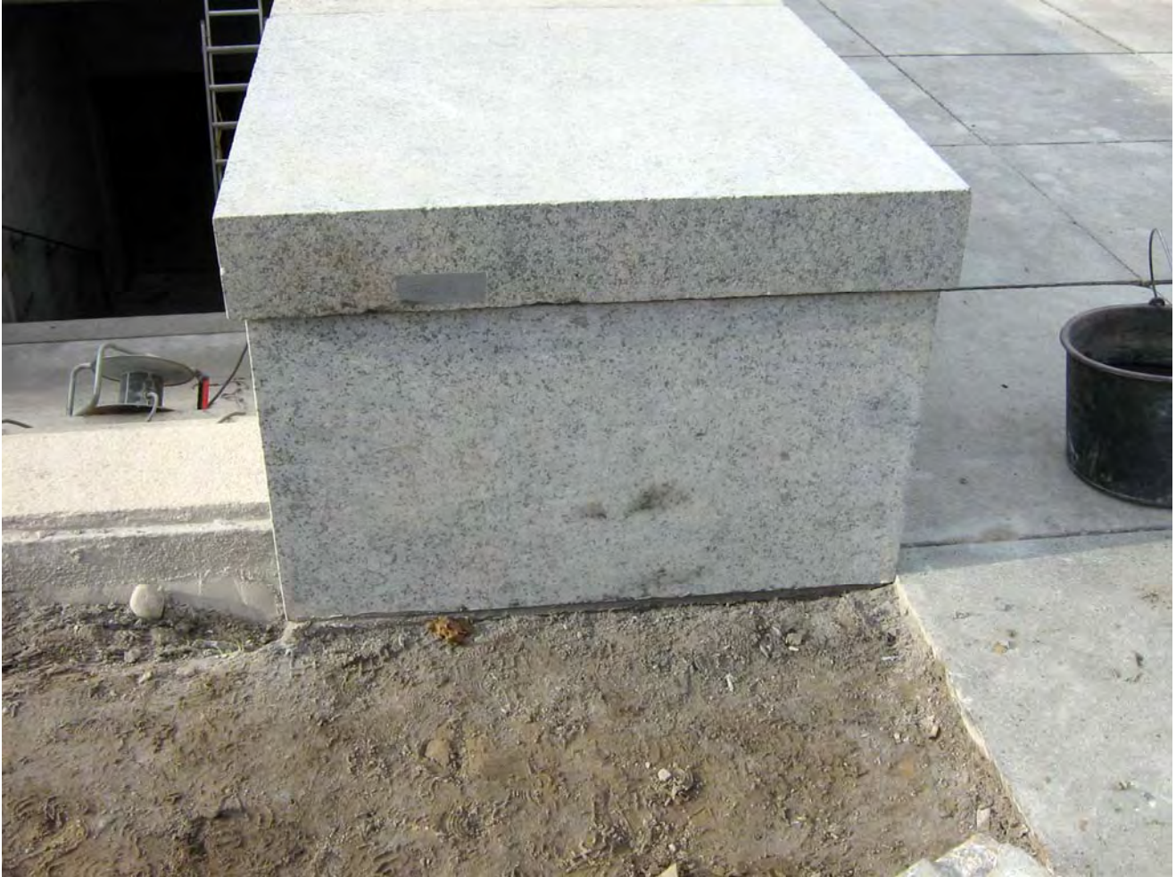
Abbildung 42 Vierung als Vorplattung
