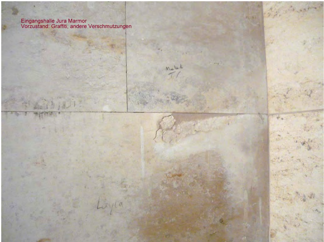
Abbildung 24 Eingangshalle, Verschmutzungen
