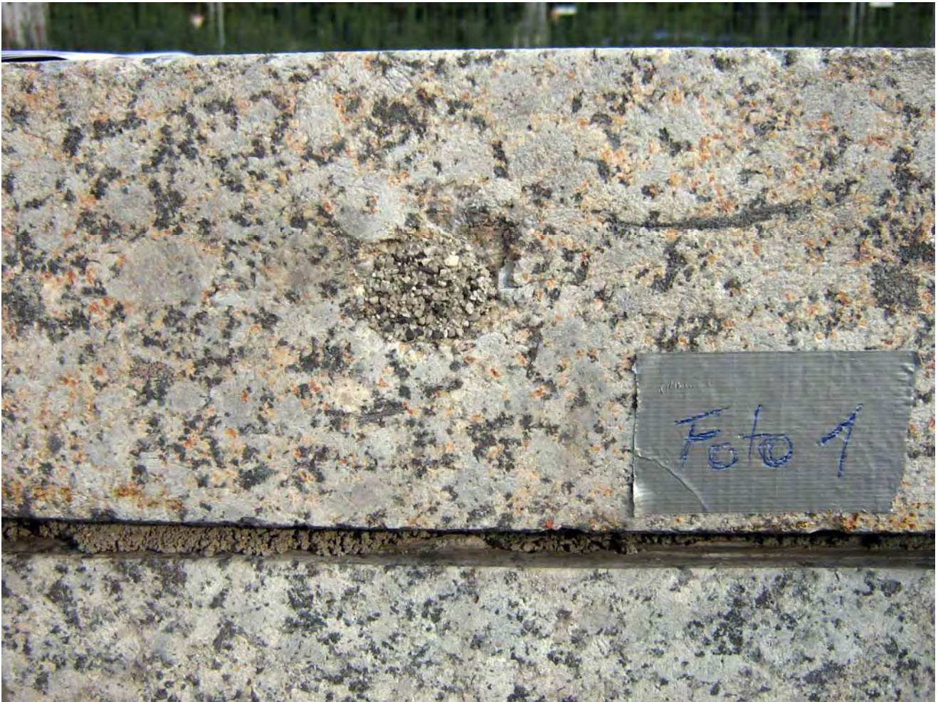
Abbildung 34 Altergänzung im Granit
