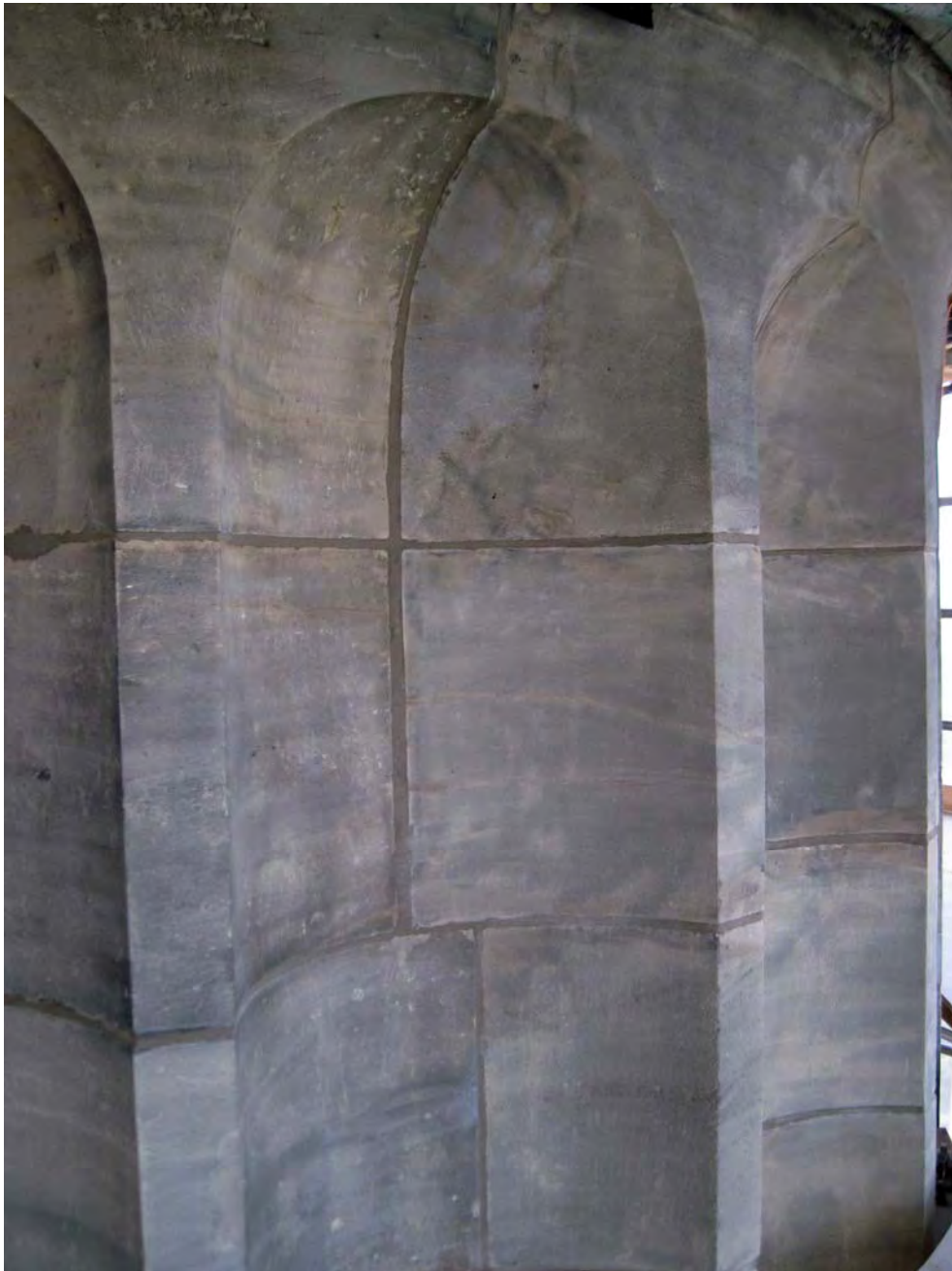
Abbildung 53 Lasur an Ergänzungen und Vierungen
