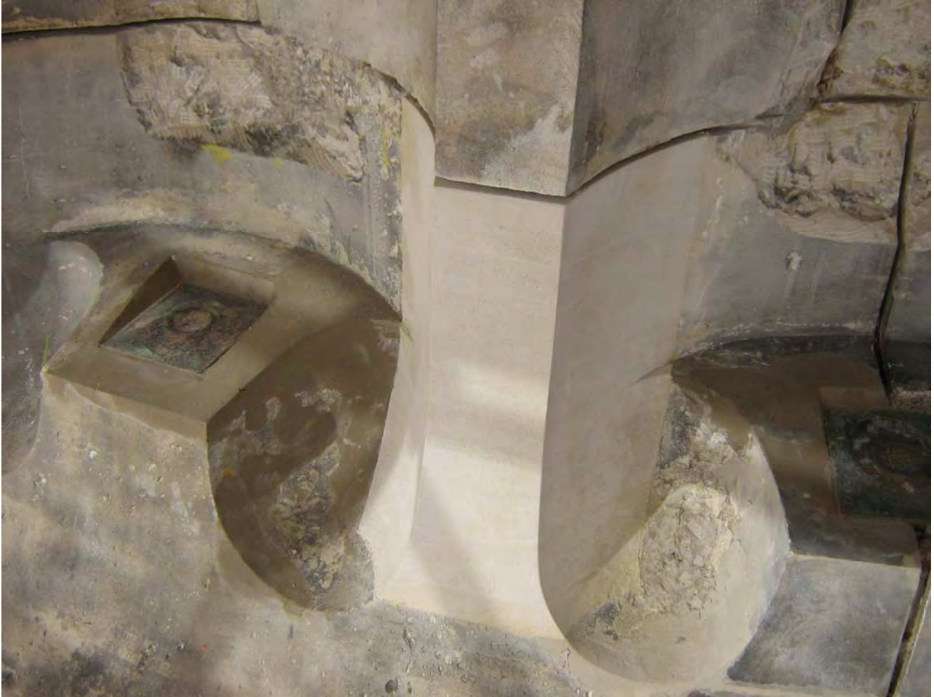
Abbildung 20 Vierung und Ergänzungen an Kanonenaufstand
