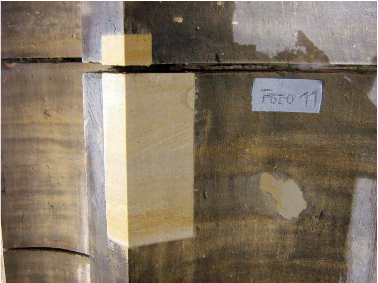
Abbildung 7 Vierung und erneuerte Ergänzung
