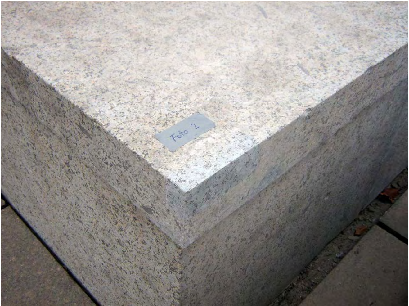
Abbildung 39 Vierung an Ecke
