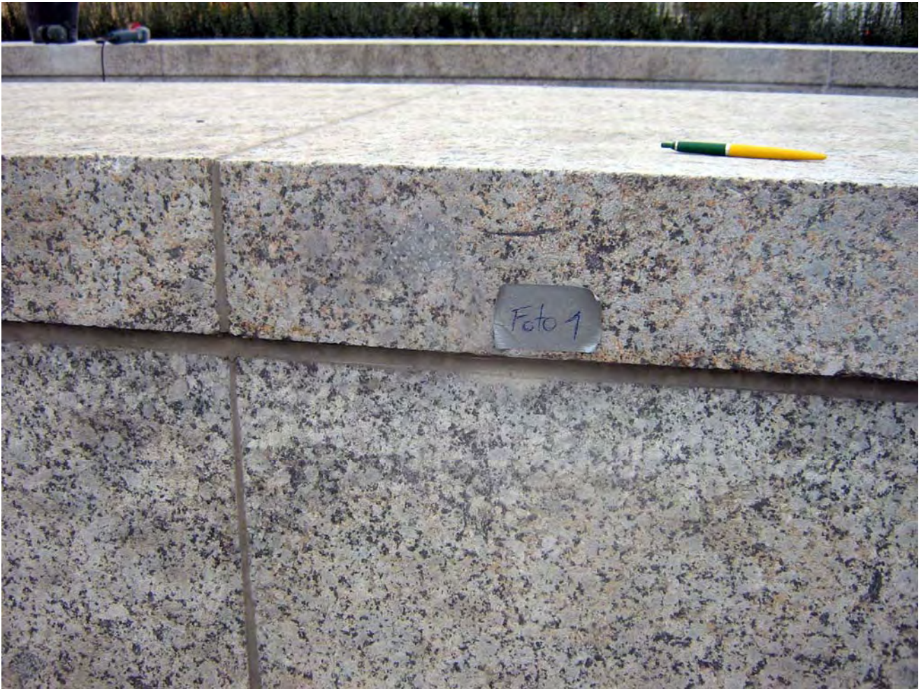
Abbildung 36 Ergänzung im Granit
