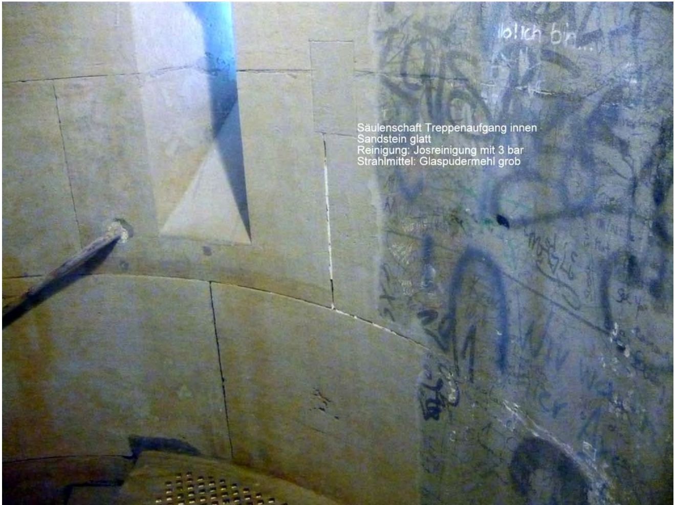
Abbildung 29 Treppenaufgang mit Reinigungsprobe
