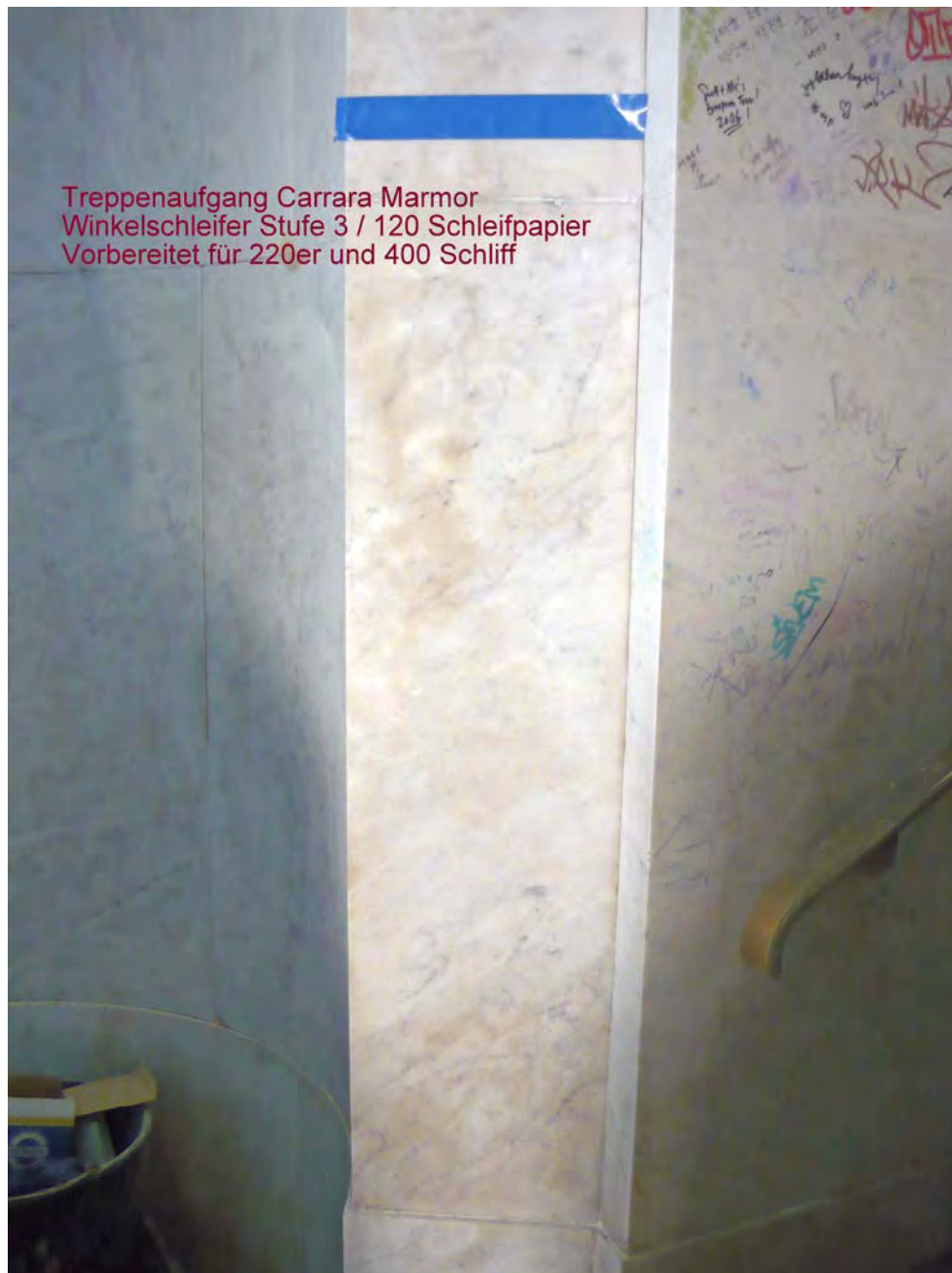
Abbildung 26 Treppenaufgang Schleifprobe
