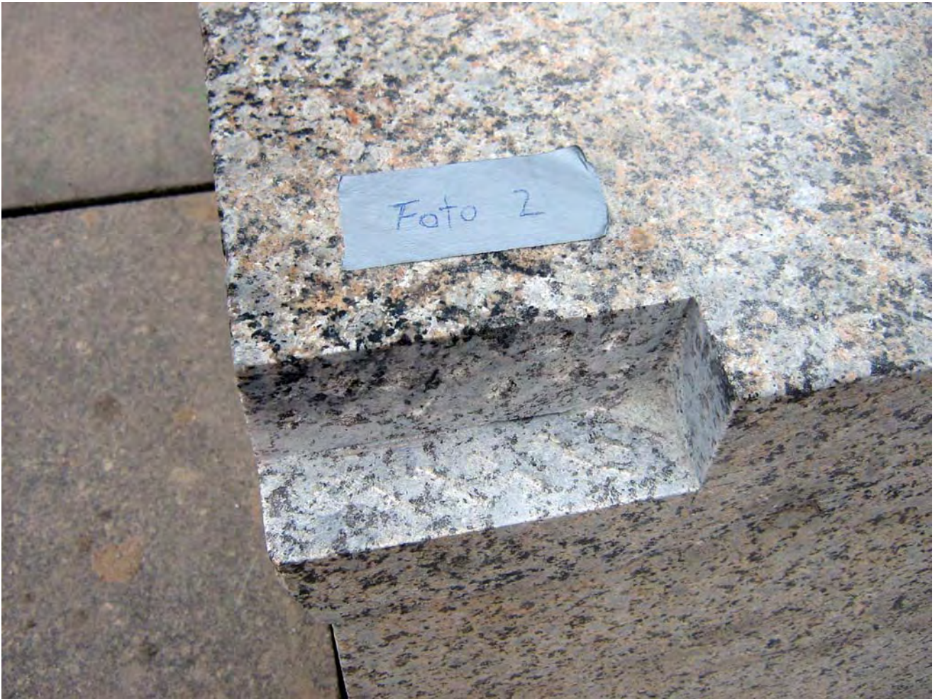
Abbildung 38 Ausarbeitung des Ausbruches
