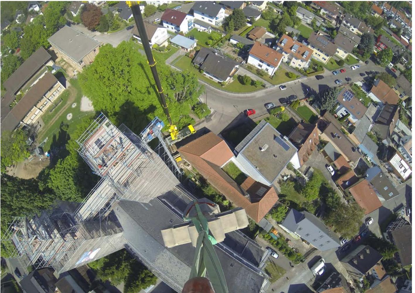
Rückbau und abheben der Turmkreuze zur Erneuerung und teilweisen Konservierung der alten Verklammerung
