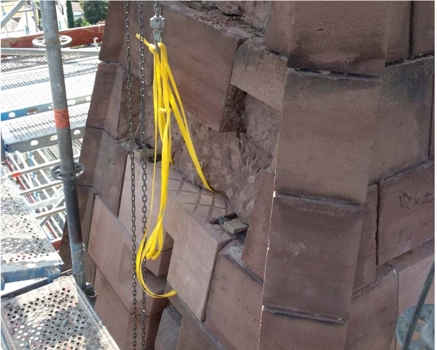
Einbau der profilierten Neuteil mit Einarbeitung der Halteklammern im Bestand
