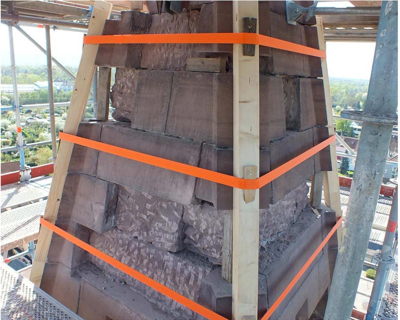
Vorrübergehende Stützkonstruktion während der Herstellung der einzelnen Neuteile für den Wiedereinbau
