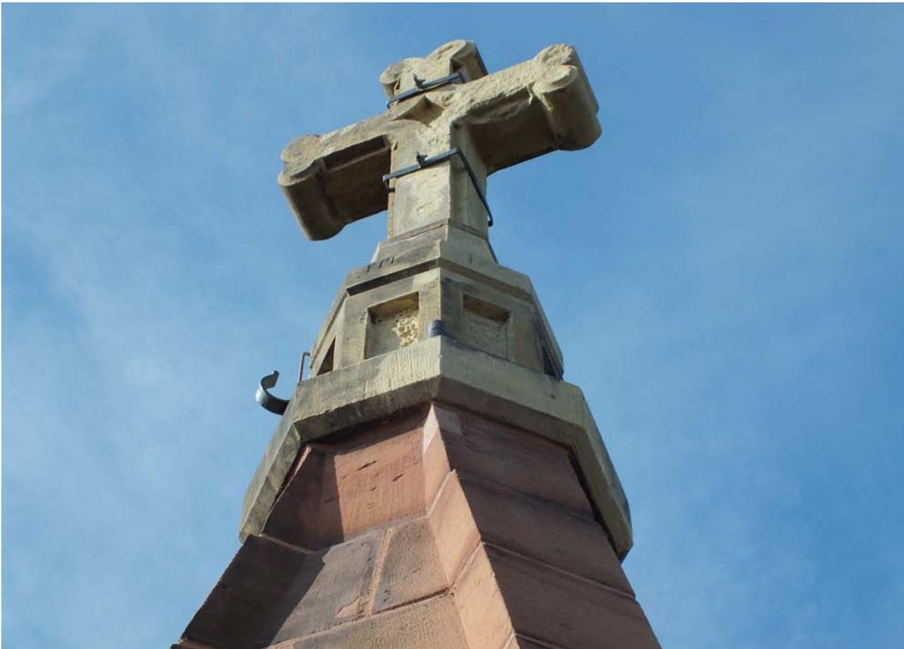
Nach Konservierung des Natursteins und Halteklammern in der Aufstandsfläche - neu aufgesetztes Turmkreuz
