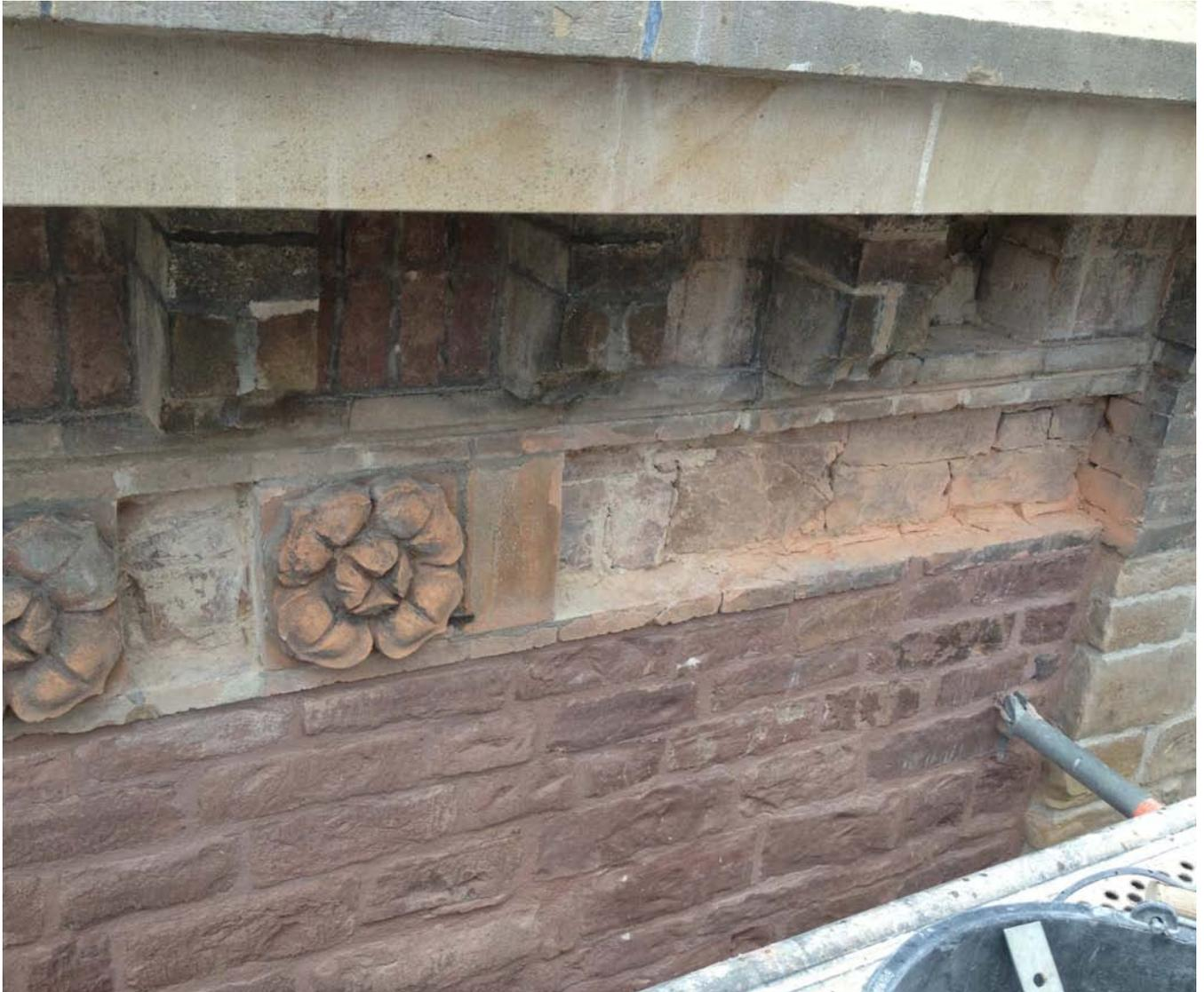
Ausgearbeitete Schadstelle zur Vorbereitung des Einbaus der neuen Zierelemente
