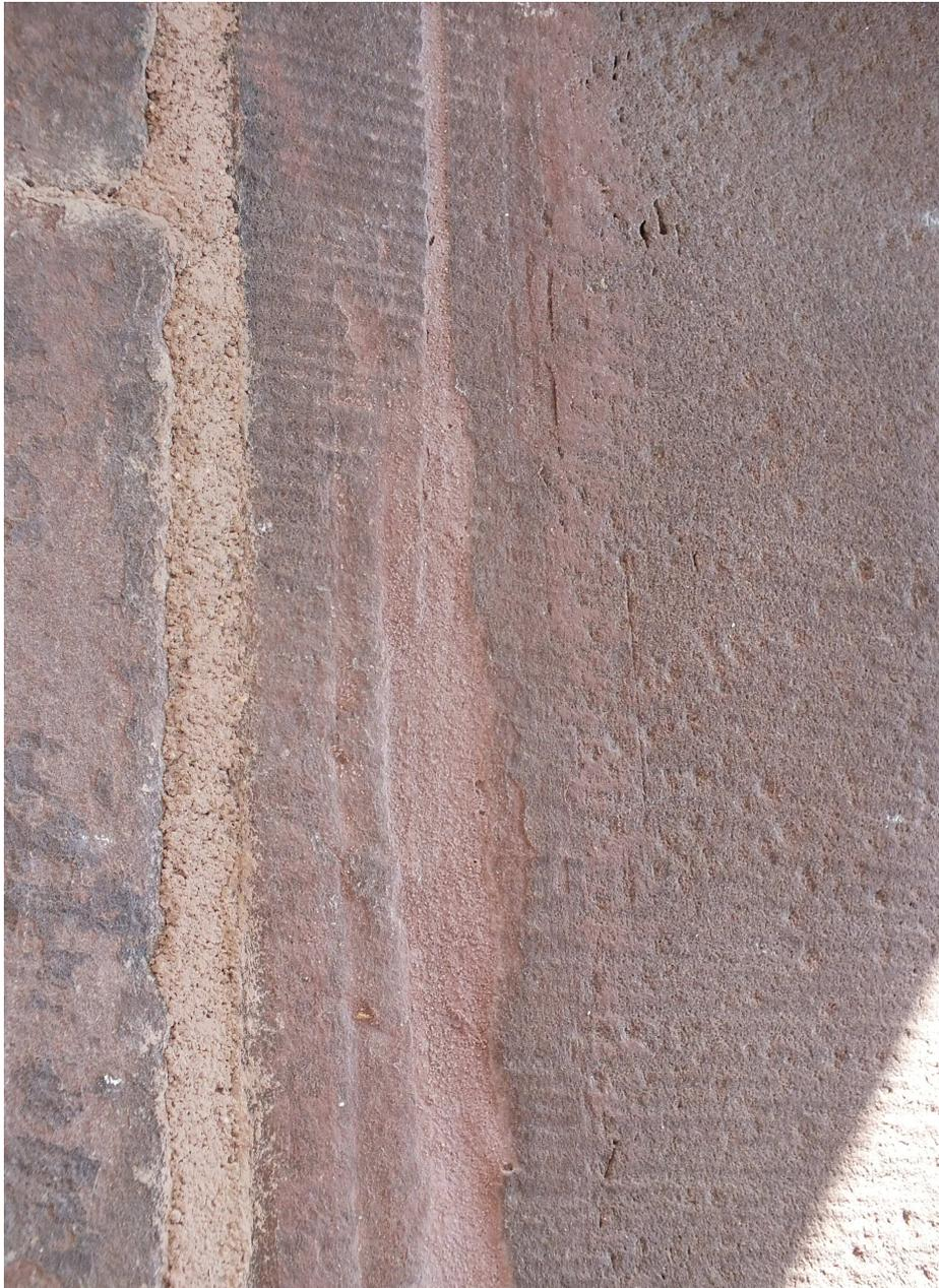
Nach Rissinjektion Verschluss mit mineralischer
