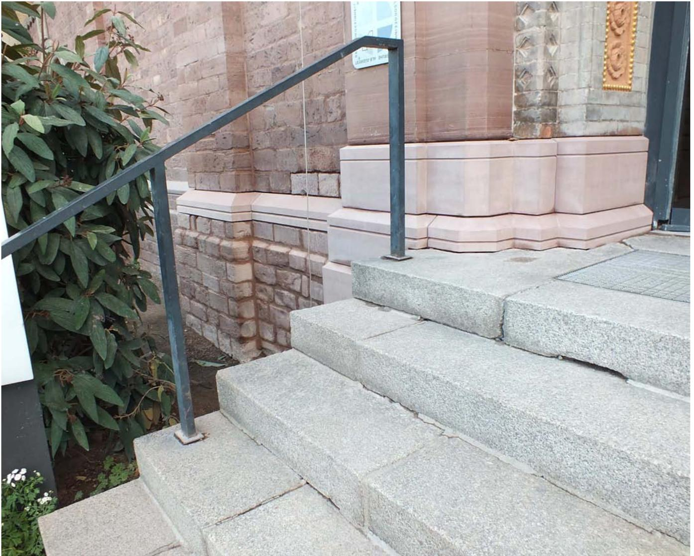
Neuteile des Sockels mit Profilierung nach Bestand
