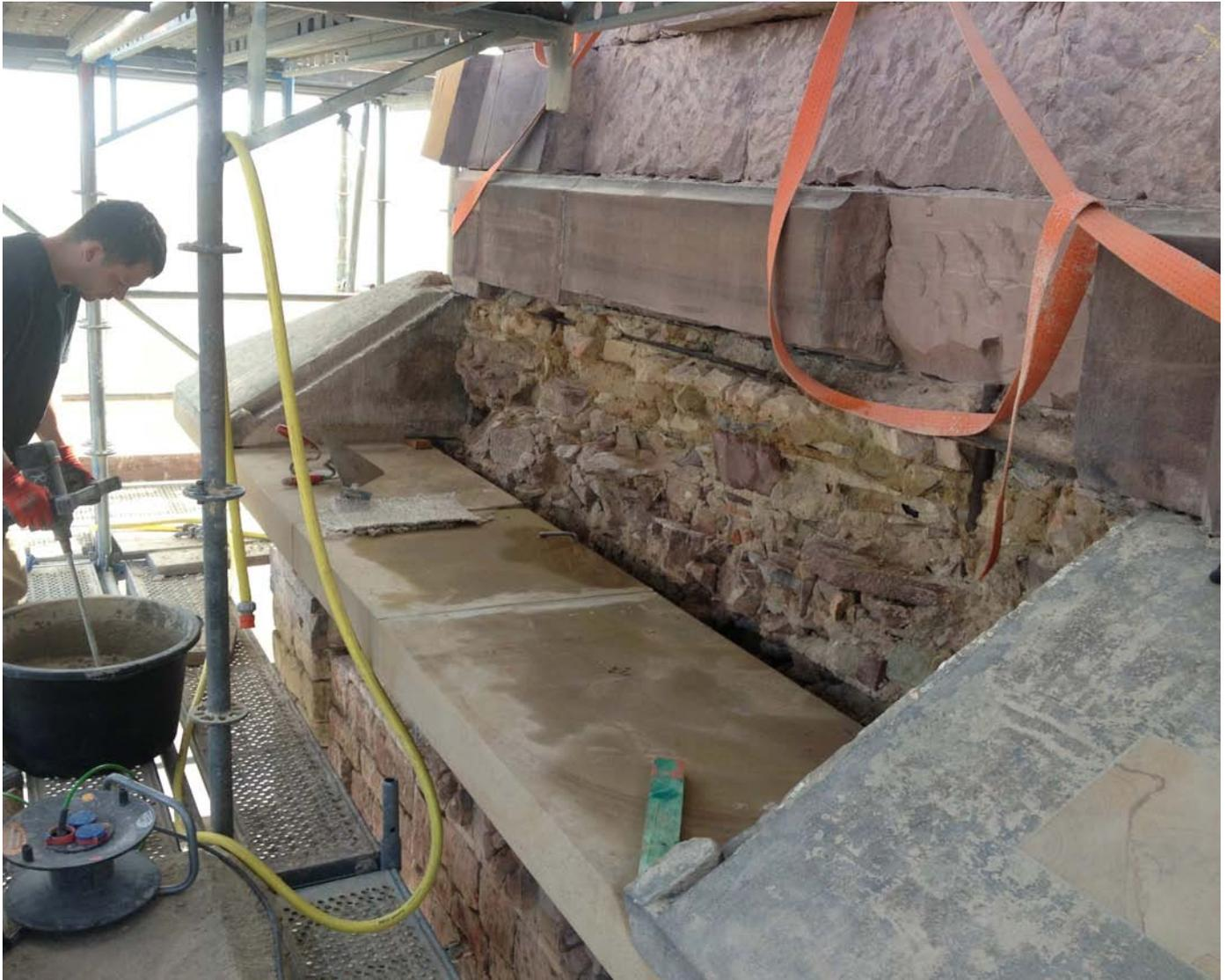
Erneuerung des Traufgesimses nach Rückbau der Turmhelmverdachung und des Hintermauerwerks
