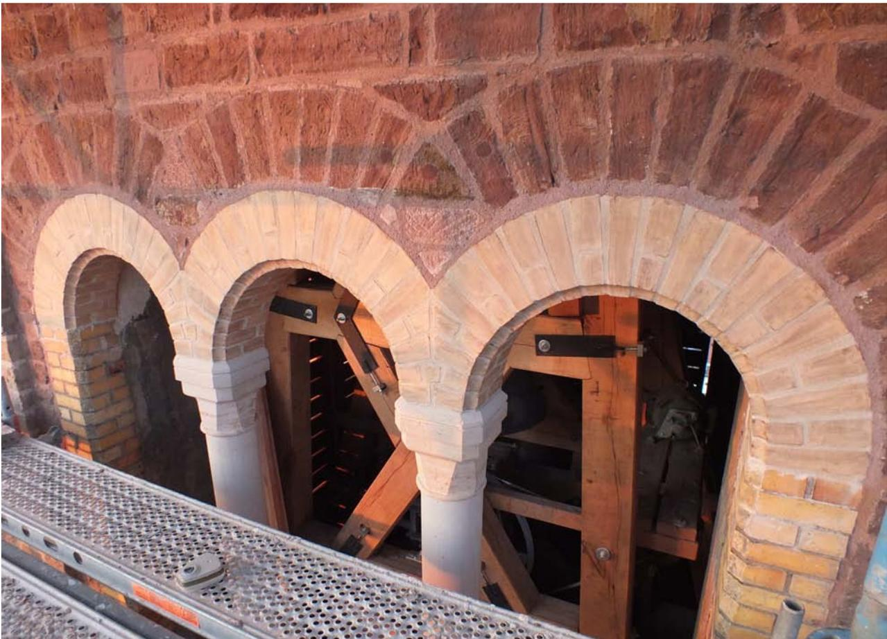
Neu gemauerte Bögen mit Säulen aus Haardter Sandstein am Glockenstuhl. Durch leichte Lasur Anpassung an den Bestand.
