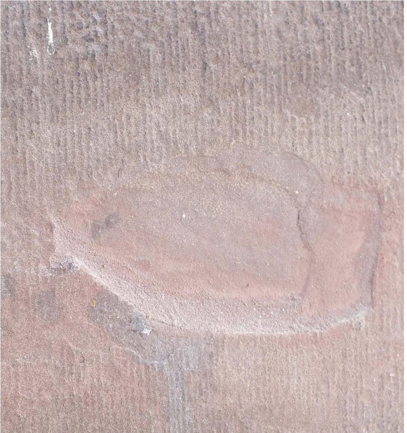
Hinterfüllte Schale mit mineralischer Anböschung gegen direkten Wassereintrag
