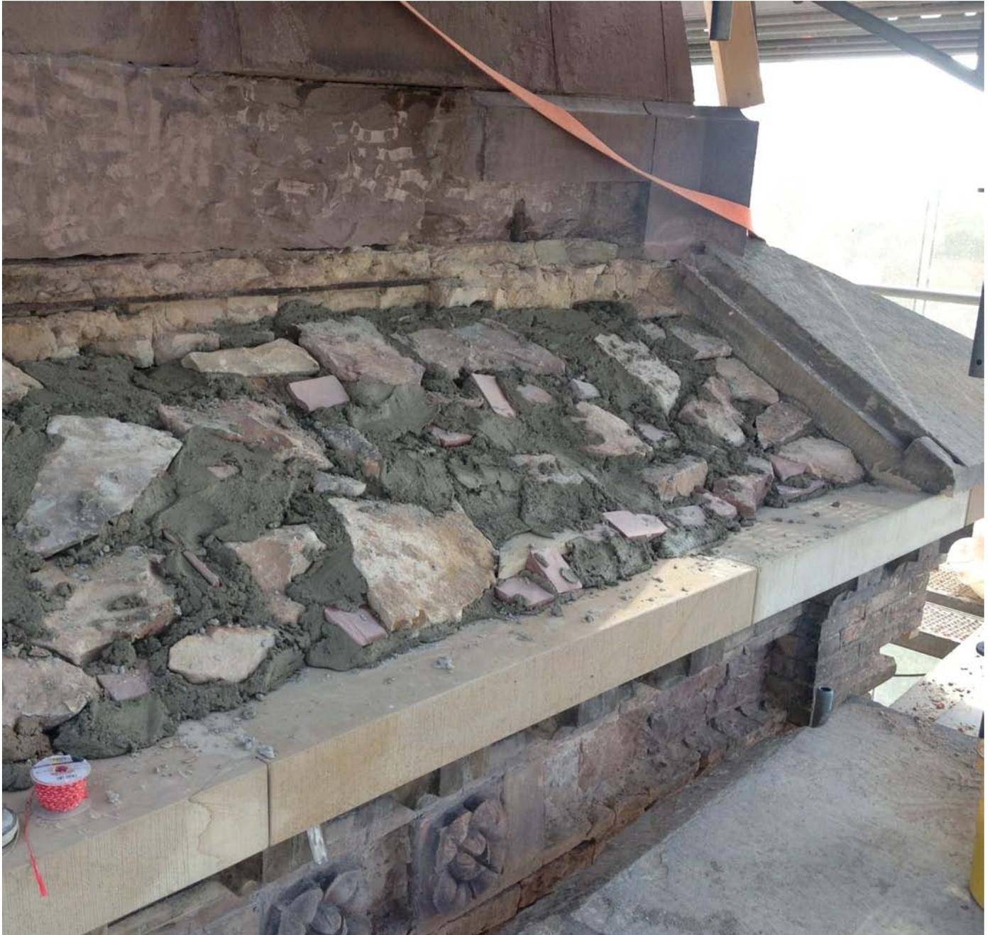
Nach Einbau der Traufgesimsteile - Wiederherstellung
