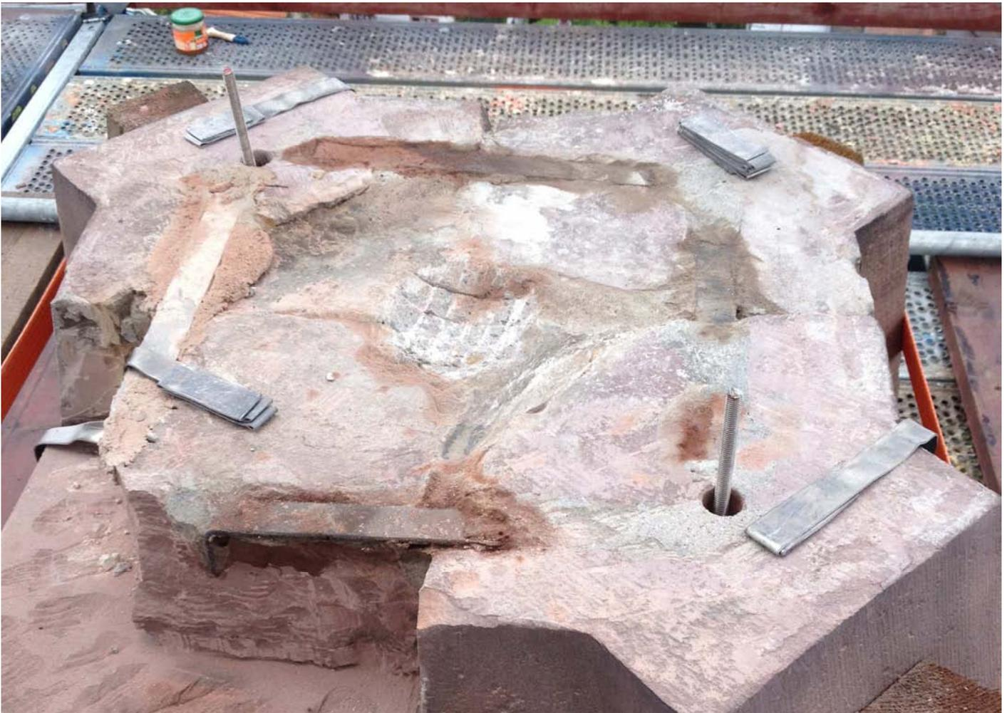
Aufstandsfläche der Turmkreuze mit teilweise neuen und konservierten Halteklammern (Auflager in Walzblei)
