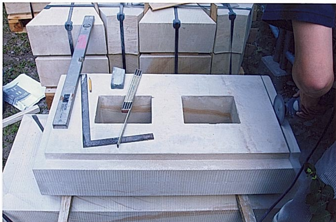
Ansicht Dach Ostseite Bauteil Essenkopf Nr. 18 Kategorie Bearbeitung Kommentar Einarbeitung der Tropfkante
