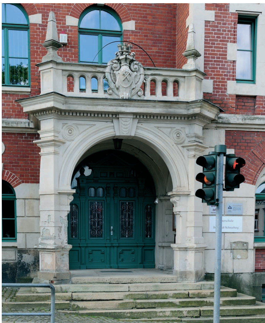
Portalansicht vor der Sanierung
