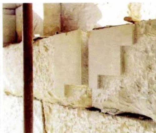
Fachgerechte Ausspitzung des Natursteins für die Ergänzung mit MINÉROS
