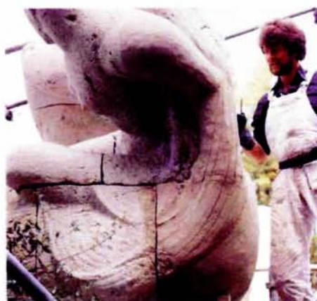
Im Abbindestadium von MINÉROS erfolgt die oberflächige Anpassung an den Originalstein
