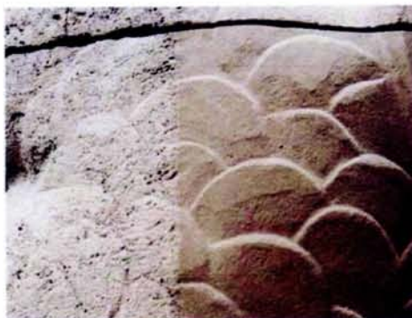
Die fertig restaurierte Schadstelle ist dem Originalstein angepaßt
