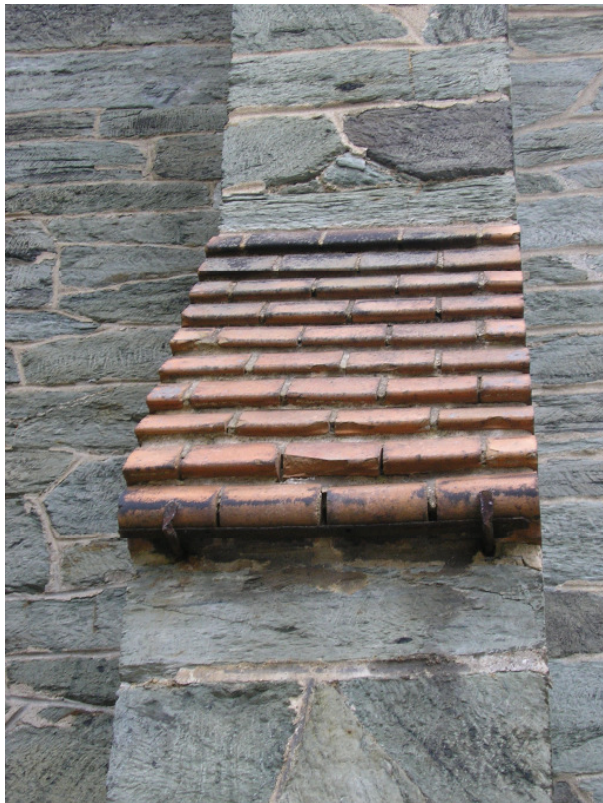
Bild 6: Unterstützung Stützfeilerabdeckung neu aus Edelstahl
