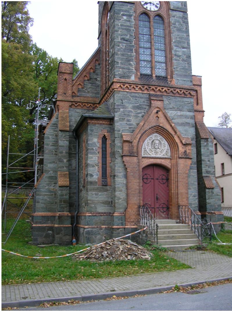
Bild 10: Südostansicht der Kirche mit Treppenbau am Turm
